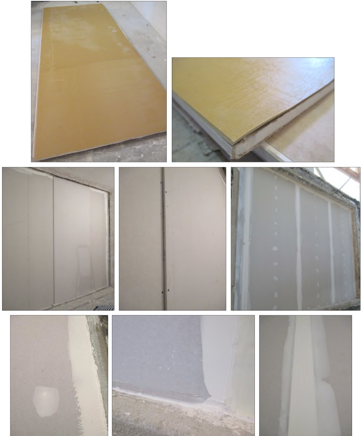
Imágenes 21 a 28 Construcción de la muestra
