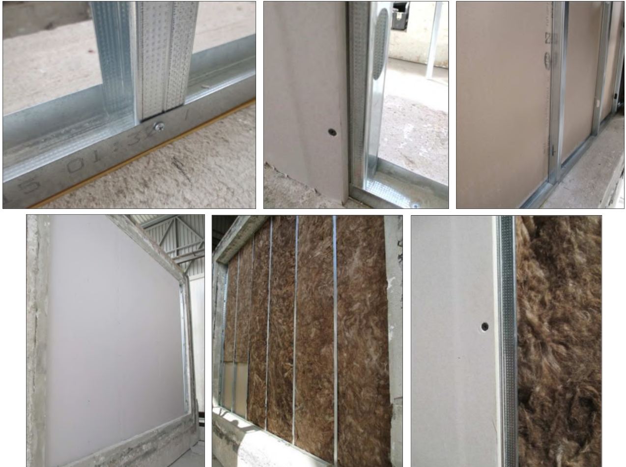
Imágenes 15 a 20 Construcción de la muestra
